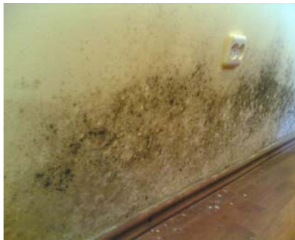
Fig. 4. Mold/dampness exterior wall (bedroom)
